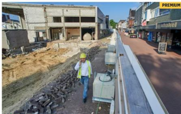
▲ Bas Timmers loopt en belt, op de bouwplaats van het Walkwartier. © Jeroen Appels / Van Assendelft Fotografie
