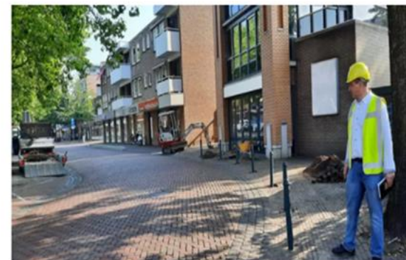
▲ Bas Timmers bekijkt de bocht in de Carmelietenstraat. Hier zijn net paaltjes geplaatst om voetgangers te beschermen tegen bouwverkeer. © Maarten van den Hurk / BD
