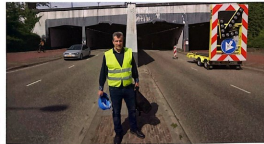
Duidelijke demarcatie tussen bouwplaats en omgeving.
