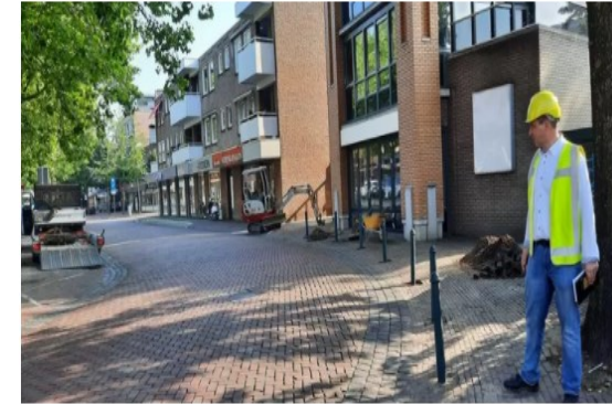
▲ Bas Timmers bekijkt de bocht in de Carmelietenstraat. Hier zijn net paaltjes geplaatst om voetgangers te beschermen tegen bouwverkeer. © Maarten van den Hurk / BD
