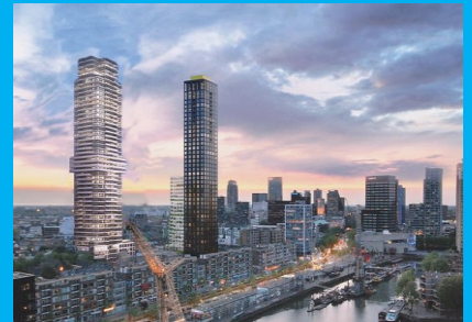
The Baantower (VO) https://www.thebaantower.nl Rotterdam
