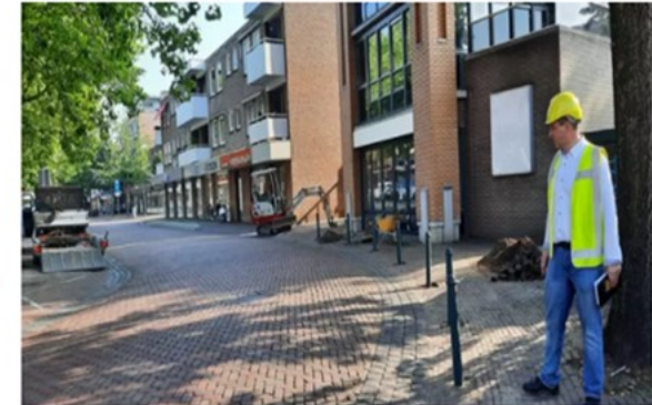
▲ Bas Timmers bekijkt de bocht in de Carmelietenstraat. Hier zijn net paaltjes geplaatst om voetgangers te beschermen tegen bouwverkeer. © Maarten van den Hurk / BD
